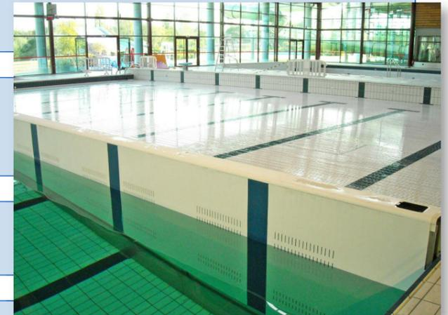
Fond mobile en position haute avec mur de sécurité
