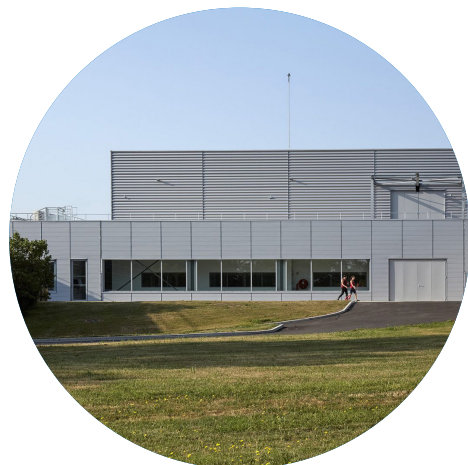
BIOMÉRIEUX BÂTIMENT 65 MARCY L'ÉTOILE (69)
