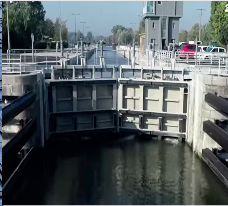
Automatisation de l'écluse de Don
