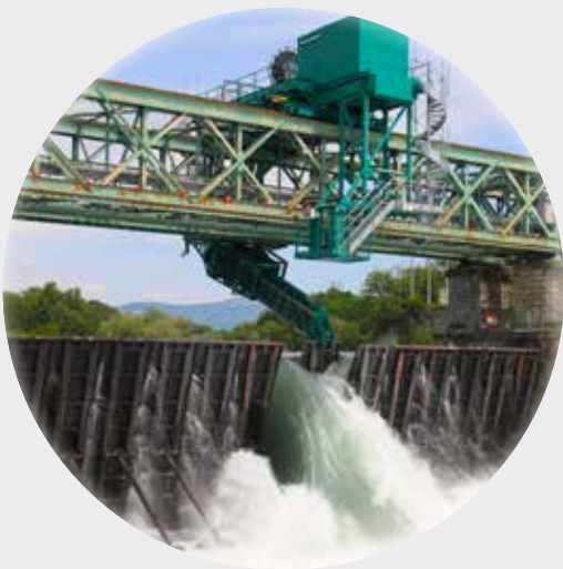
Barrage de Seyssel (74)
