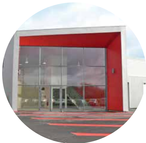
Centre logistique hospitalier TROYES (10)
