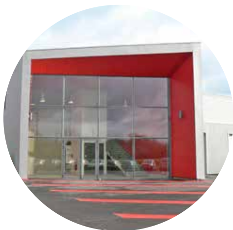
Centre logistique hospitalier TROYES (10)
