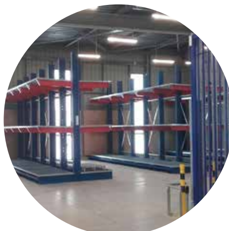
Magasin relais et bureau de contrôle transport CNPE FLAMANVILLE (50)
