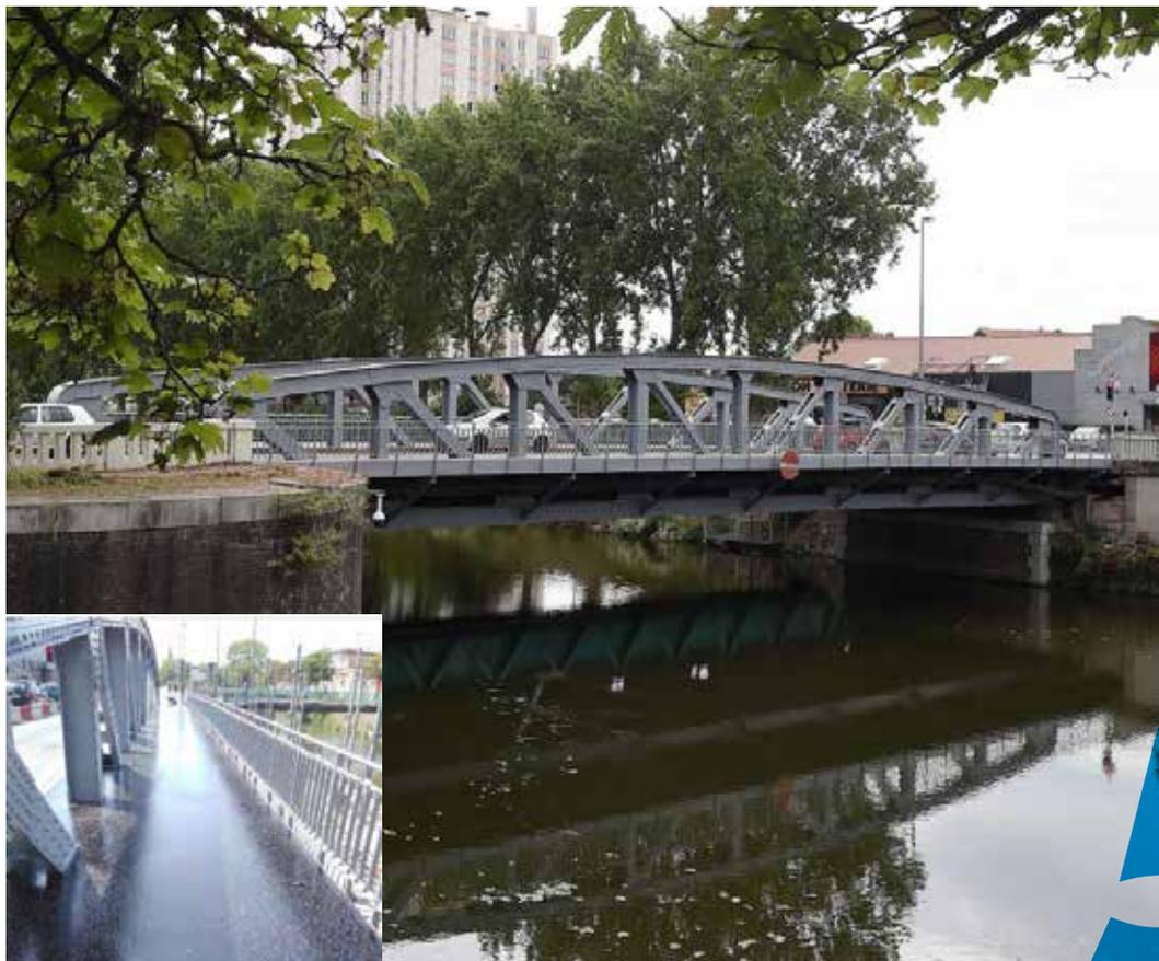
DUMANOIS a pris en charge la réparation métallique du pont de Furnes à Dunkerque. Il s'agit d'un pont à structure métallique de type DAYDE détruit durant la guerre et reconstruit en 1958. Après confinement et sablage du pont, les éclisses et goussets ont été posés avec 2 800 rivets à chaud. Les éléments de métalleries (garde-corps...) ont été fabriqués par BC MÉTAL-NORD. Durant 9 mois, les travaux se sont déroulés en gardant la circulation sur une voie centrale.
