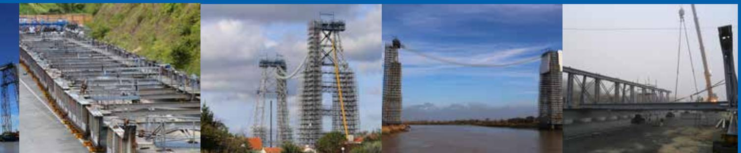
• Dépose des câbles et des selles et évacuation du tablier et des câbles
