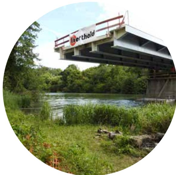
Le groupement OUVRAGES D'ART DE L'EST / BERTHOLD a réalisé les travaux de reconstruction de l'ouvrage d'art permettant à la RD546 de franchir l'Aisne. Le pont routier, entièrement métallique a nécessité le reconditionnement des culées et de la pile
