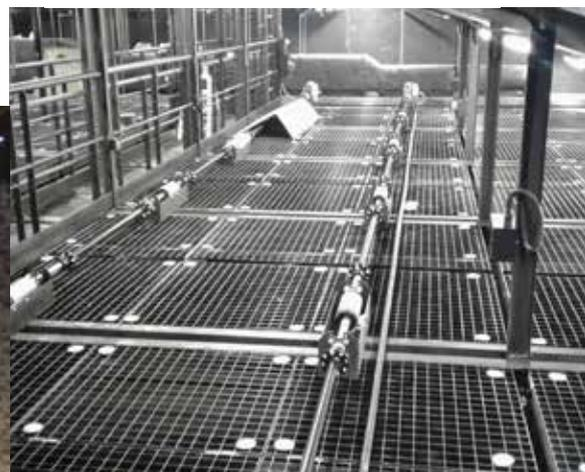
Gril technique avec les équipes motorisées et la passerelle escamotable (à gauche)
