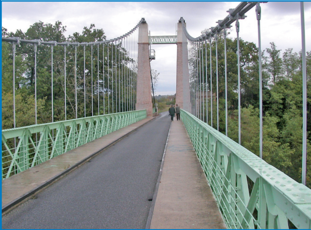
Maitre d'ouvrage : CG DU TARN
