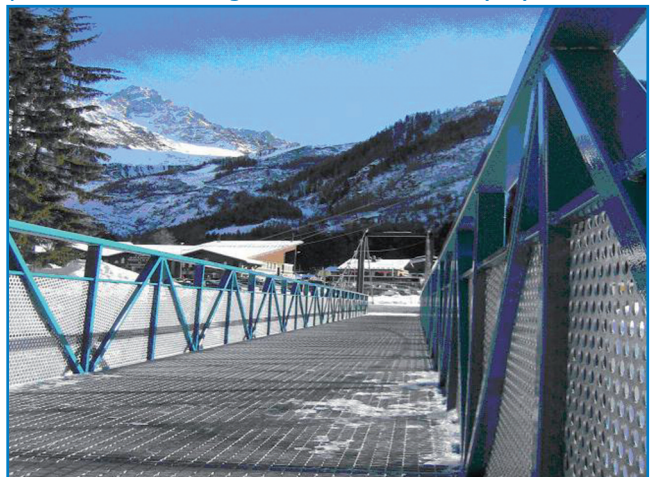
Maître d'ouvrage : MAIRIE DE CHAMONIX Maître d'œuvre : B&M ENGINEERING
