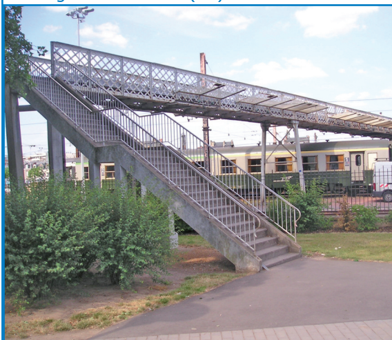
Maître d'ouvrage / Maître d'œuvre : VILLE DE TOURS
