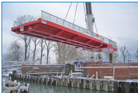
Maître d'ouvrage : WHITE SANDS SA Maître d'œuvre : ZSCHOKKE
