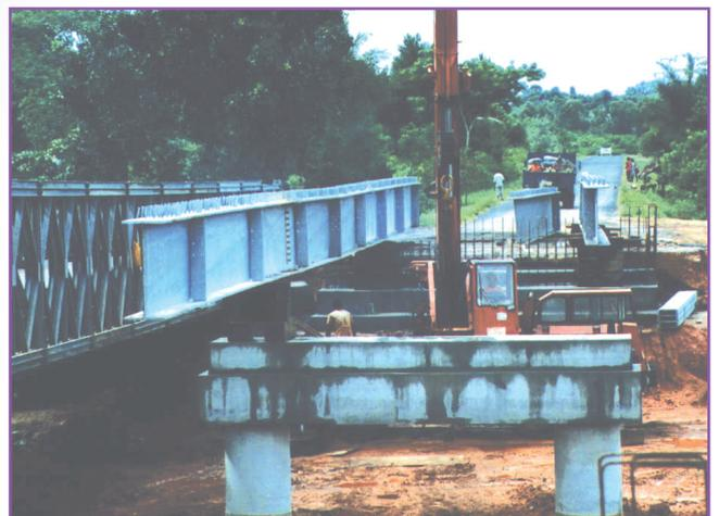
Madagascar : remplacement par levage d'un pont provisoire par un pont BC
