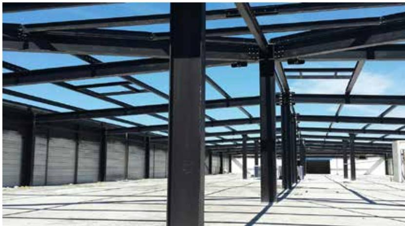
Les travaux consistaient à poser la structure sur une dalle béton R+1 conservée en étayant au préalable les
