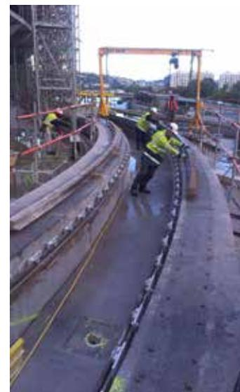
*Mise en place des rails de roulement de la Voile*
