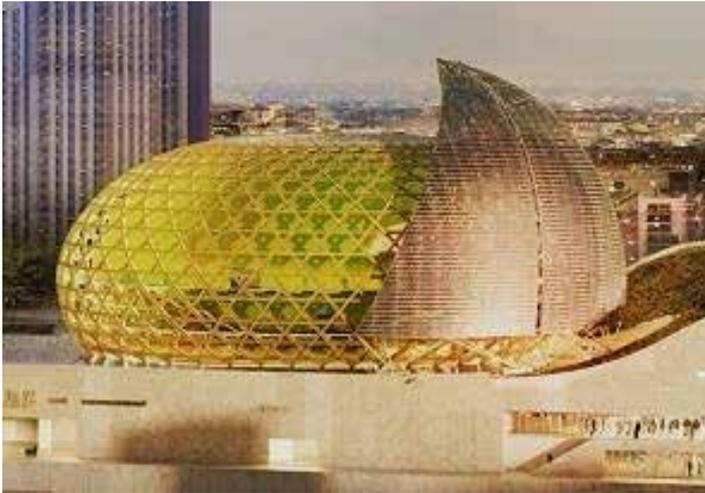
La Voile, ouvrage en charpente métallique, est le support d'un écran de panneaux photovoltaïques (environ 850 m<sup>2</sup>). Elle circule autour du bâtiment phare du projet de la Cité de la musique, l'Auditorium, en suivant le soleil pour capter un maximum de luminosité. Elle est située sur la terrasse N1 de l'Auditorium et au-dessus de la verrière principale et se compose de deux ouvrages (voiles) tridimensionnels, symétriques, contigus et mobiles (dimensions d'environ 22 x 40 m chacun).
