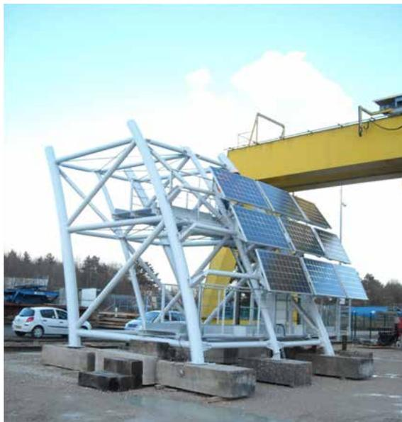
Depuis août 2014, BAUDIN CHATEAUNEUF œuvre sur le projet de la "Voile". Cette structure métallique tubulaire d'environ 35 m de haut recevra sur sa nappe extérieure environ 750 m<sup>2</sup> de panneaux photovoltaïques. Cette "Voile" sera motorisée par le service Génie Mécanique afin que celle-ci se déplace tous les jours en fonction de l'ensoleillement.
