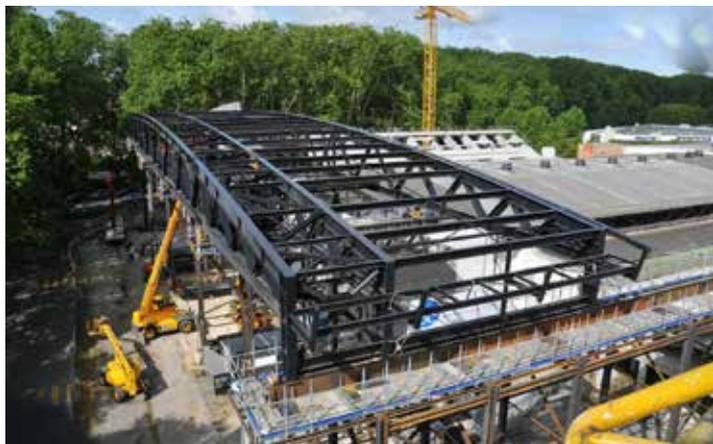
Dans le cadre de l'agrandissement du Palais des Sports de la Ville de Bourges (18), BAUDIN CHATEAUNEUF a réalisé la charpente métallique principale constituée de 8 poutres treillis de 75 m de portée, de pannes de toitures et de passerelles techniques de 9 m de portée. Cette structure de 450 t a été assemblée sur une structure provisoire et nécessité un ripage réalisé par
