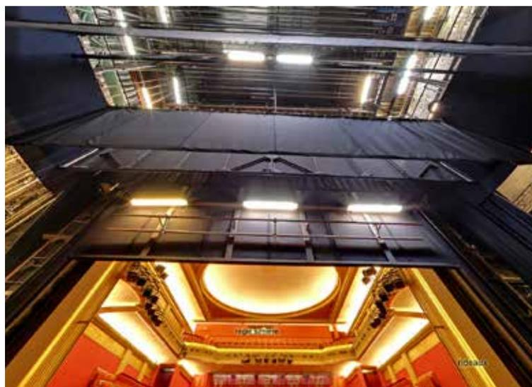
Après la charpente, le Département Génie Mécanique a refait toute la mécanique de scène, soit 25 perches manuelles, 8 treuils motorisés et 4 treuils manuels, ainsi que l'installation d'un système de pilotage BAUDIN CHATEAUNEUF.
