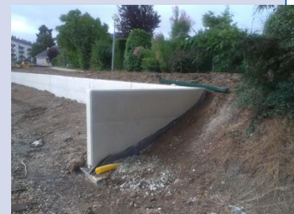
Mur de Lucé
