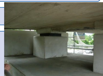
Nouveaux appareils d'appuis avec reconstitution bossages
