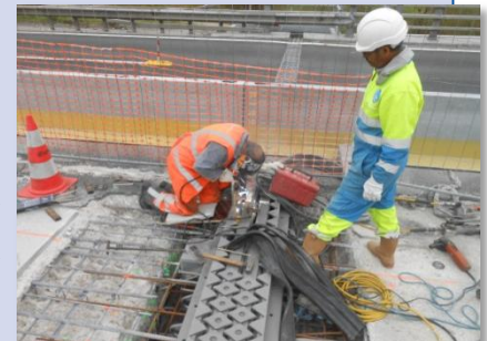
Rabotage du joint seconde phase
