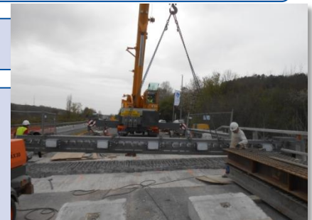
Mise en place du joint
