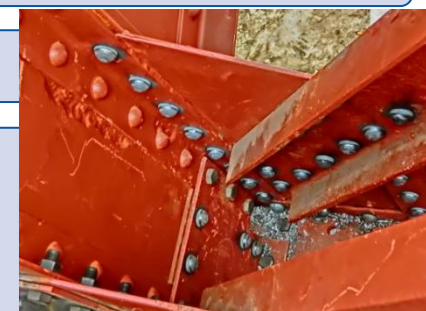
Rivets à chaud
