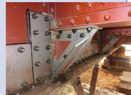
Réparation et renfort de la structure
