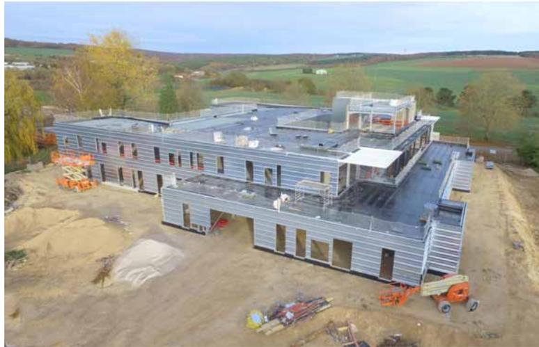
La division Charpente de BERTHOLD a fabriqué et mis en œuvre 210 t de charpente y compris l'ossature de façades composée de 150 chevêtres, ainsi que les escaliers de se-
