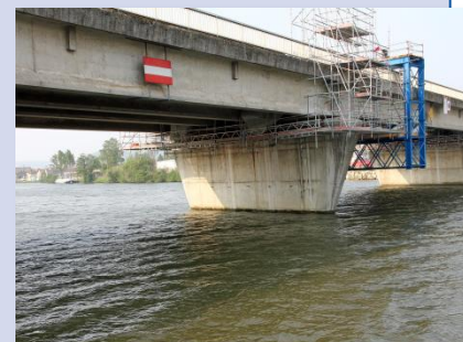
Echafaudage sur pile
