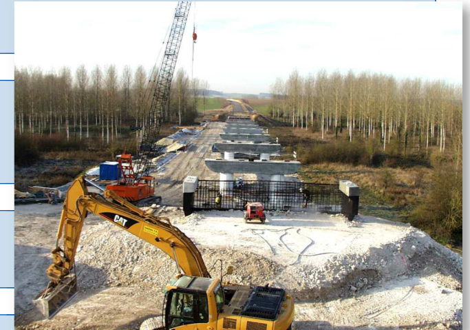
En cours de travaux
