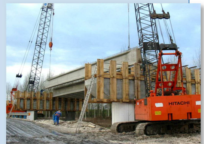
Pose des poutres précontraintes
