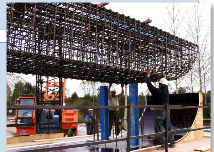
Ferrillage des chevêtres de piles
