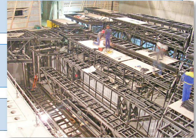
Ossature des tables de scènes mobiles
