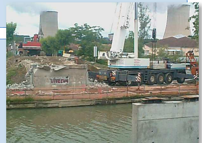
Ouvrage existant après enlèvement du tablier
