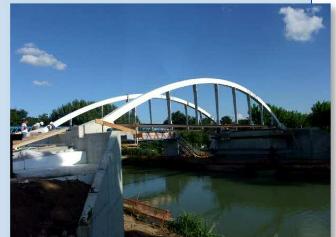
Pose des arcs métalliques
