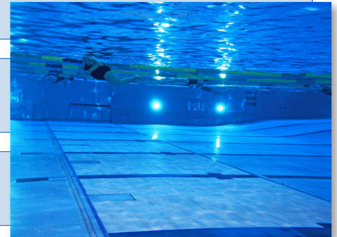
Mur mobile abaissé
