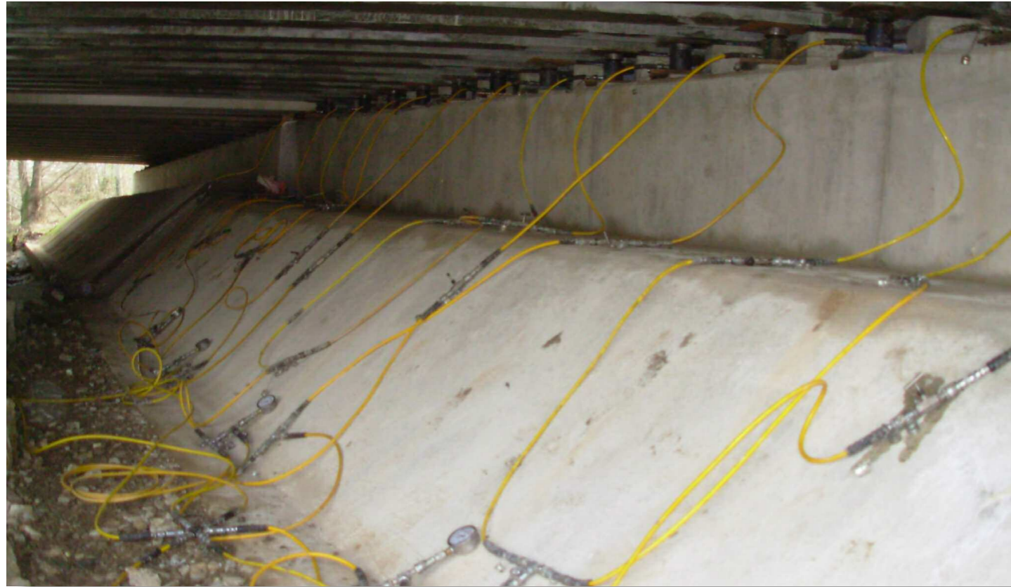
Vérinage des poutres
