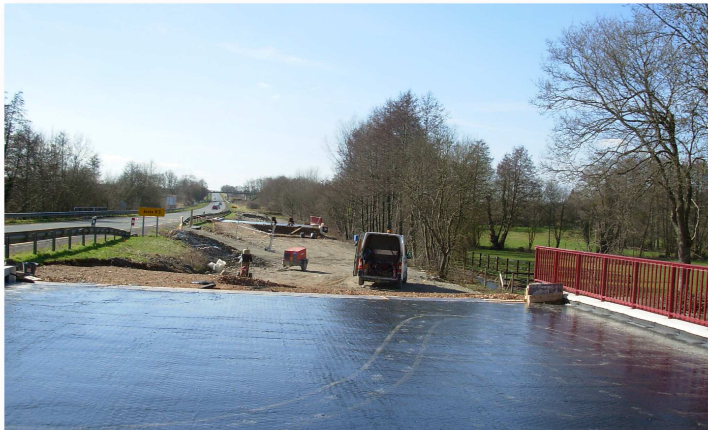
Tablier après réalisation étanchéité
