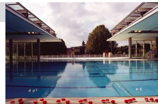
toiture et façade ouverte
