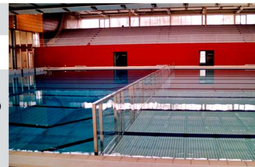
fond relevé et garde-corps en place
