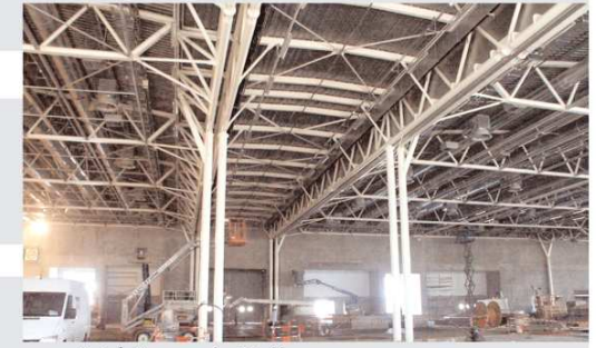
vue intérieure du Hall
