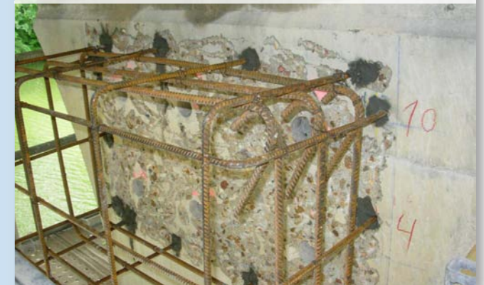
Création du massif de vérinage pour changement appareils d'appuis
