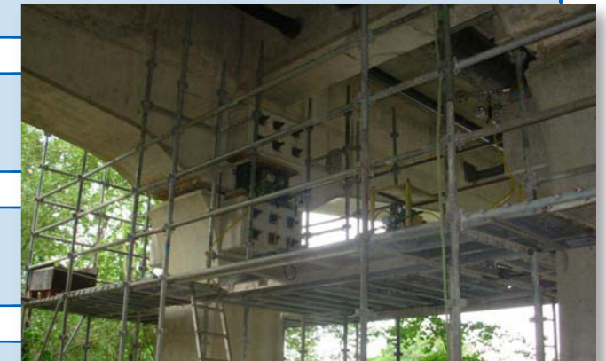
Création du massif de vérinage pour changement appareils d'appuis
