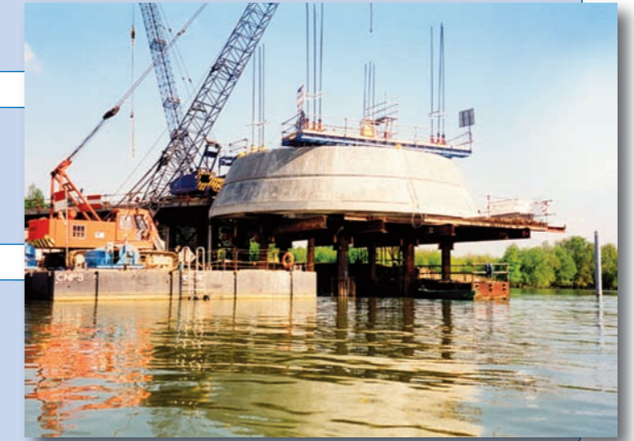
Fabrication et immersion progressive d'une pile (650 T)
