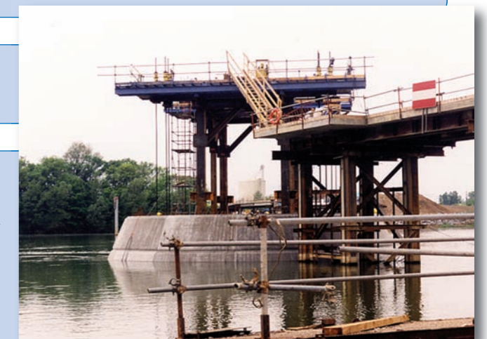
Clavage d'une pile sur 10 pieux de fondation (diamètre : 1,60 m)
