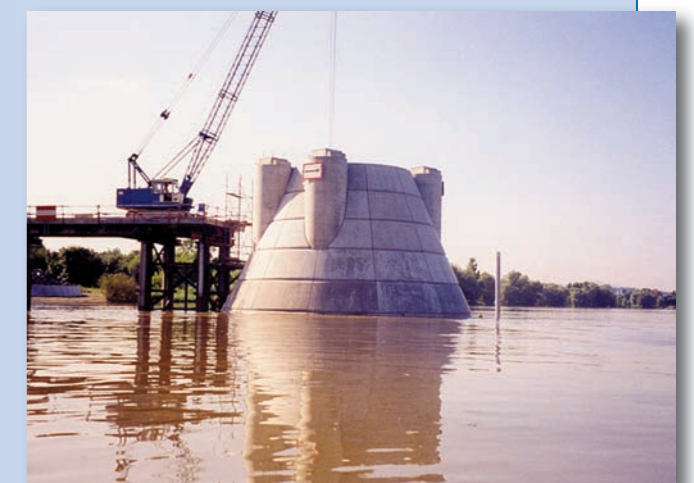
Fin de la construction d'une pile du pont
