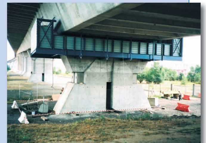
Changement des appareils d'appuis sur piles et culées, vérinage (11 x 6 000 T)
