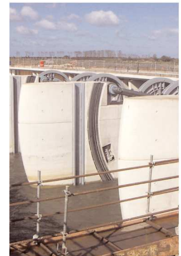
fourniture et montage de la vantellerie
