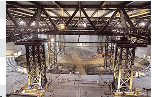
montage des poutres maîtresses
