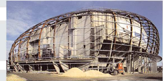
montage de la charpente extérieure
