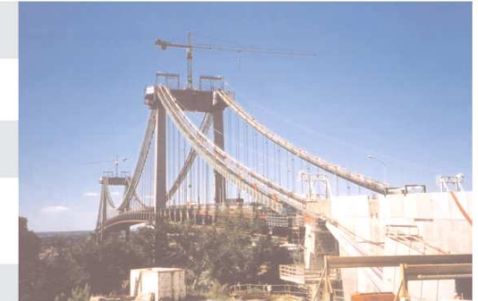
systemes de vérinage sur les anciennes et les nouvelles suspentes
