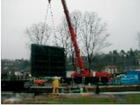
> Dépose de l'ancienne porte
