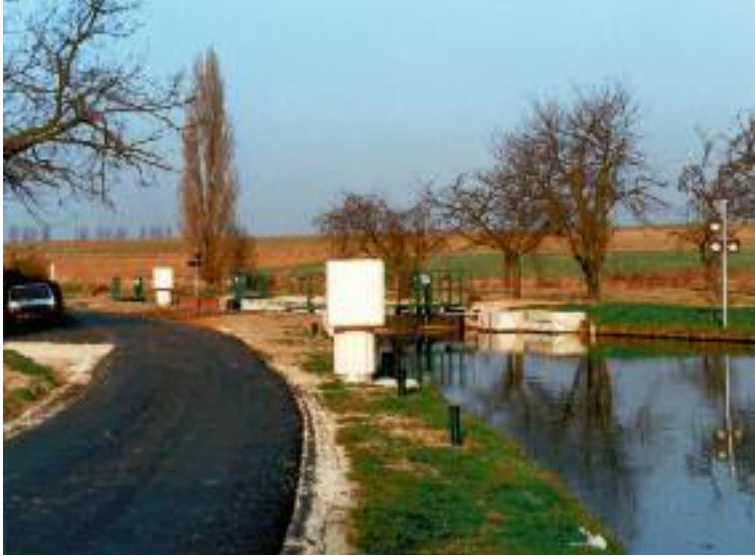
> Borne de commande de manœuvre de l'écluse
