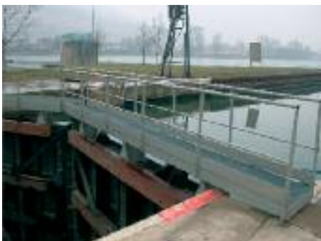
> Détail sur la passerelle
