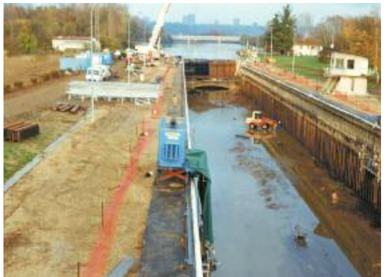
< Curage du sas de l'écluse
