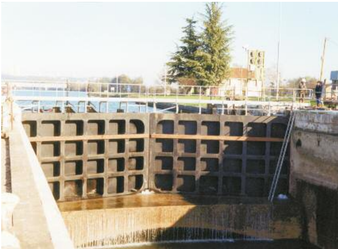
> Essais de la nouvelle porte amont
