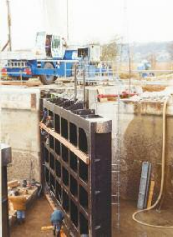
> Pose des étanchéités basses sur la porte amont
