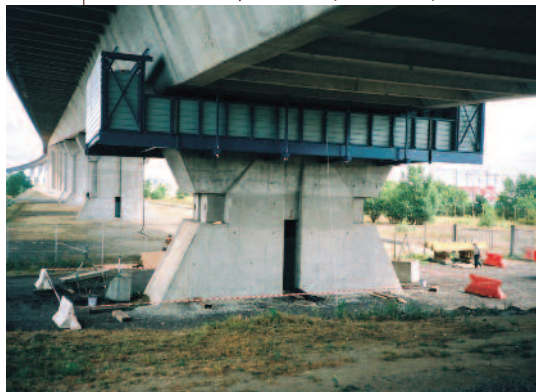
4- PONT DE CHEVIRÉ - NANTES (44) : CHANGEMENT DES APPAREILS D'APPUI SUR PILES ET CULÉES, VÉRINAGE (11 X 6 000 T)
