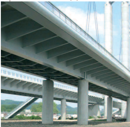
3- VIADUCS D'ACCÈS AU PONT GUSTAVE FLAUBERT SUR LA SEINE - ROUEN (76)
