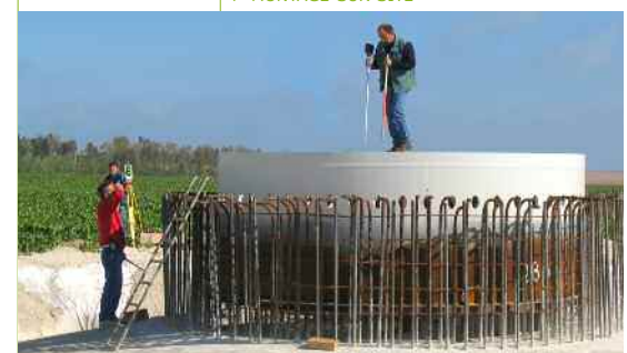
4- MONTAGE SUR SITE
