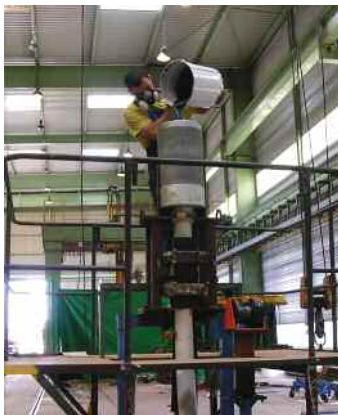
3- OPÉRATION DE CULOTTAGE D'UN CÂBLE À LA RÉSINE
