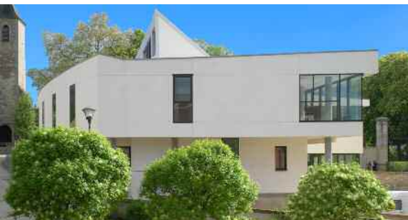
1- MÉDIATHÈQUE DE COSNE-COURS-SUR-LOIRE (58)
