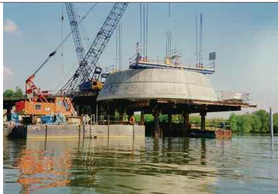
1- PONT DE JASSANS-RIOTTIER (01) : FABRICATION ET IMMERSION PROGRESSIVE D'UNE PILE (650 T)
