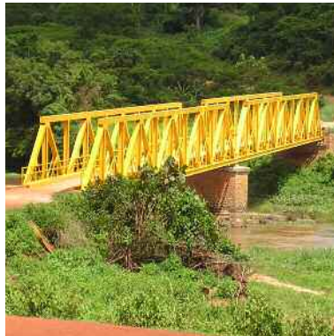
4- PONT SUR LA MAMBÉRÉ - BANIA (AFRIQUE)
