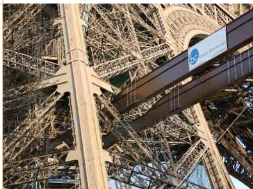
1- ASCENSEUR OUEST DE LA TOUR EIFFEL (PARIS)
