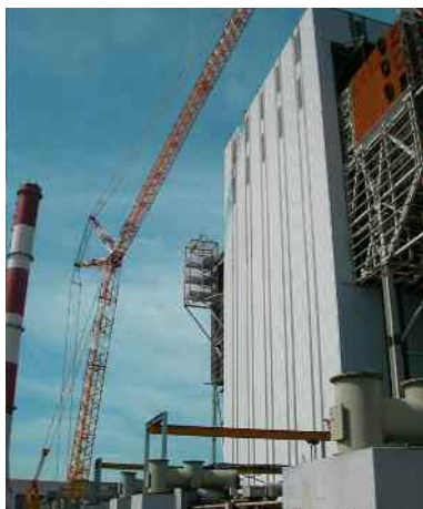
2- RÉNOVATION DE LA CENTRALE EDF DE CORDEMAIS (44)
