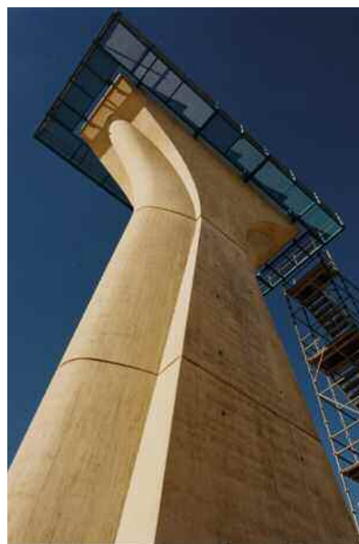
2- UNE DES PILES DU VIADUC DE L'ARC (13)
