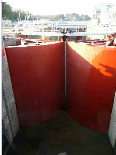
2- ÉCLUSE DE LA RANCE - SAINT-MALO (35)
