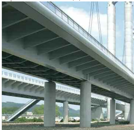
3- VIADUCS D'ACCÈS AU PONT GUSTAVE FLAUBERT SUR LA SEINE - ROUEN (76)
