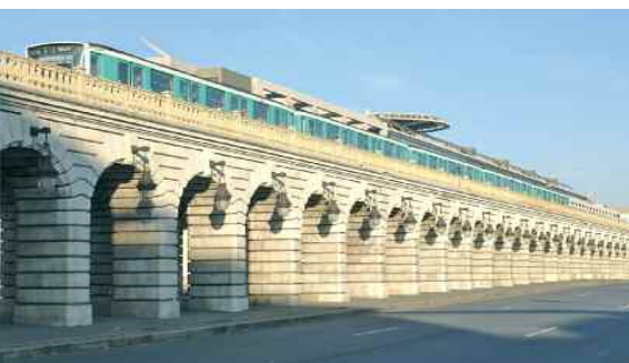
1- RÉNOVATION DU PONT DE BERCY (PARIS)
