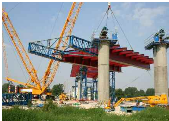
2- MONTAGE DU VIADUC SUR LE LOING (45)
