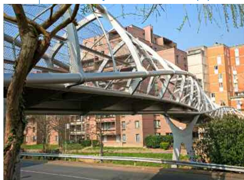
5- PASSERELLE QUAI AUX FLEURS - ÉVRY (91)
