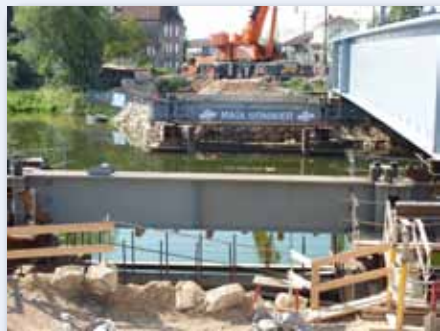
Le nouvel ouvrage vient d'être ripé le long des chemins de ripage
