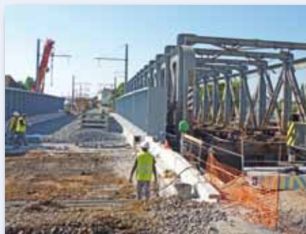
Le nouveau pont (à gauche) est mis en place à côté de l'ancien prêt à être démonté.
