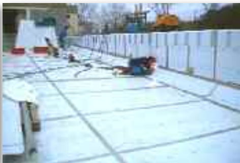
Soudure des tronçons
