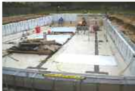
Pose des tronçons inox de côtés et fond
