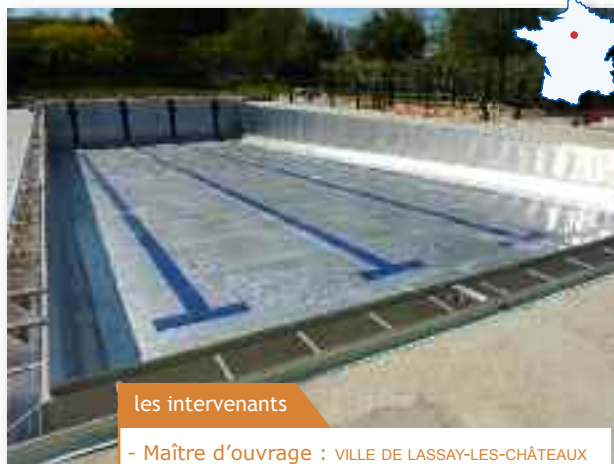
Préparation du bassin : sciage des têtes de bassin
