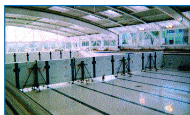
Mur mobile en cours de montage
