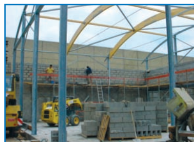
Construction de la salle de danse à Chatou (78)
