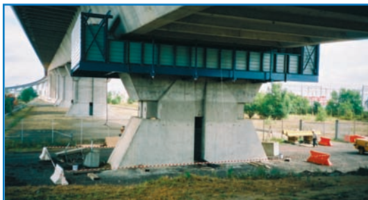
Pile du pont de Cheviré
