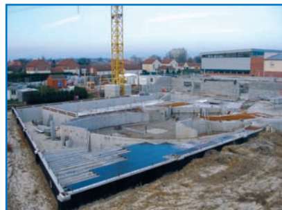
Piscine de Courrières en construction
