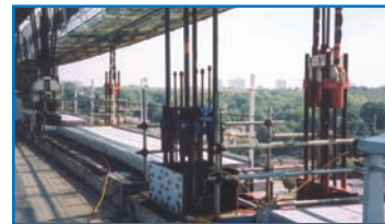
Systèmes de vérinage sur les anciennes et les nouvelles suspentes
