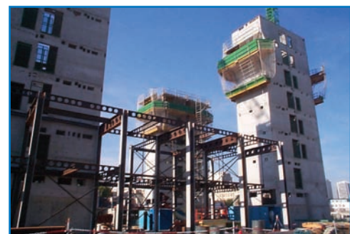
Travaux de montage en cours
