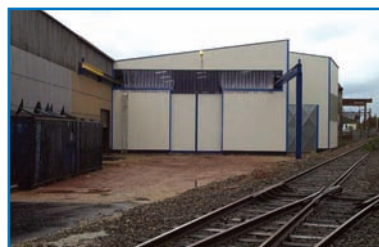
La nouvelle extension de l'atelier
