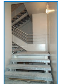
Escalier de secours
