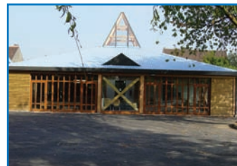
Vue extérieure du bâtiment - École D. Casanova
