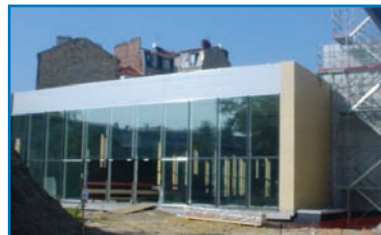
Vue extérieure de la piscine
