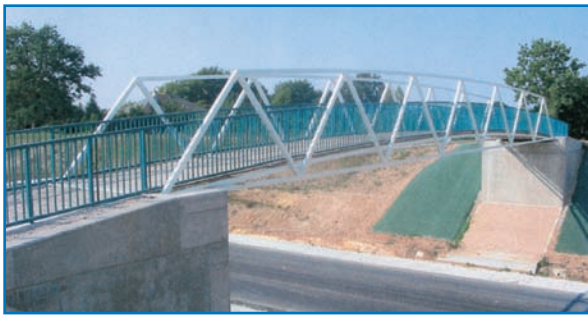
Passerelle du Chatelier (35).
