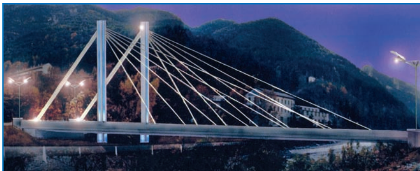
Vue de nuit du pont sur le Var à Puget Théniers (06)
