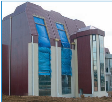
Chantier Oril GF3 à Bolbec (76) : couverture, étanchéité et bardage d'une unité de production pharmaceutique
