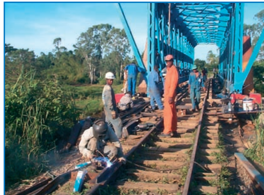
Rénovation d'un pont-rail près de Tamatave
