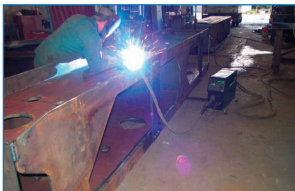
Soudure sur les nouveaux chariots destinés aux grues 15 T pour le Port de Calais - CCI DE CALAIS.
