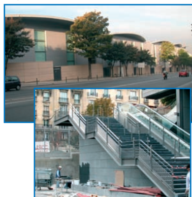
Escalier du parvis A.
