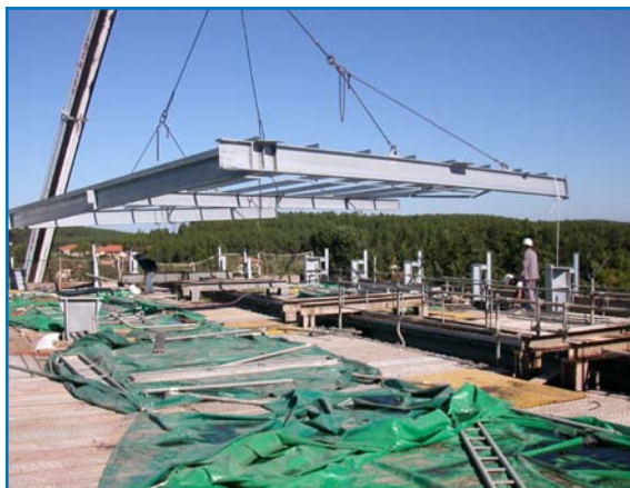
Levage d'un carré pré-assemblé constituant la charpente.
